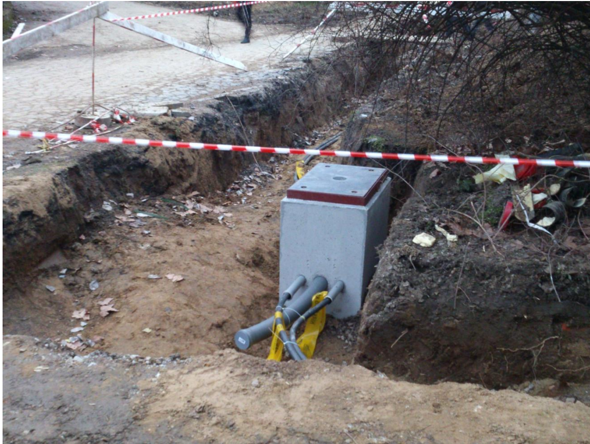
Akna a nyomvonal mellé telepítve
